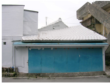
セメント瓦屋塗膜防水漬け、一部トタン埋め込み
